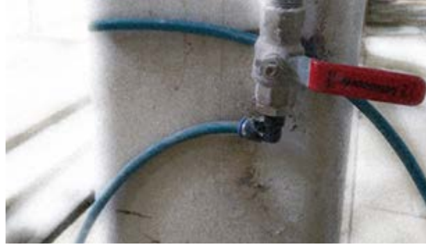
Şekil 19. Temizliğin büyük orifis çaplı hortumlarla yapılmasına örnek (hortum dış çapı Ø12 mm)
